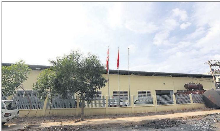
Ergofloor har på under fem år vokset sig for store til sin fabrik i Vietnam, så nu har firmaet fået bygget en ny. Den blev indviet i går.
